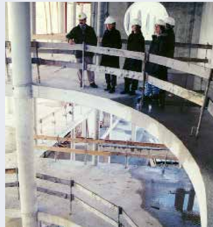
Rohbau in der Charlottenstraße 12/2
