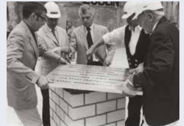
16. Juni 2000: Grundsteinlegung der neuen vhs Friedrichshafen
