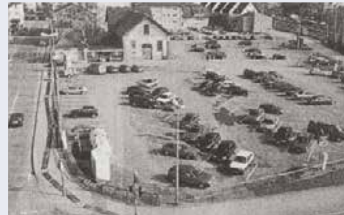
Der Charlottenhof 1998 als öffentlicher Parkplatz
